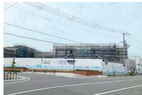
建設中のこべっこランド(旧中部下水処理場跡)
