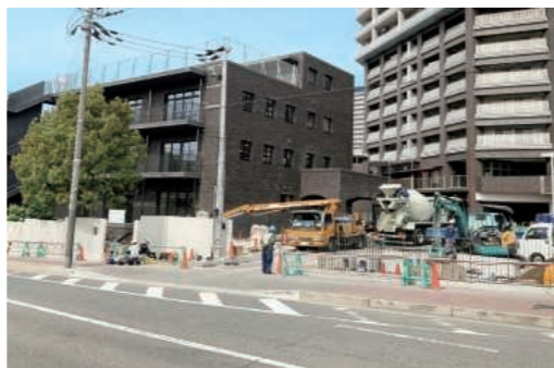
建設中保育所
